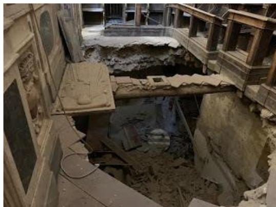
fig.15 - Crollo del pavimento
